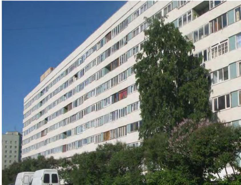
Рис. 3. Здание серии ЛГ-600. Наружные стены из автоклавного газобетона.
