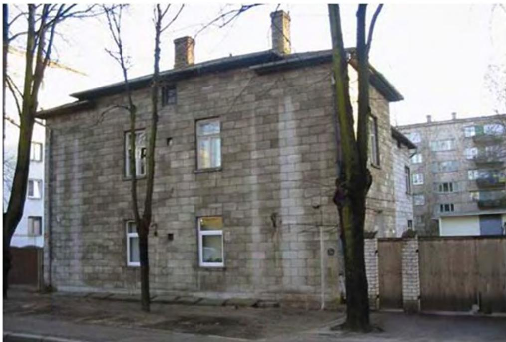
Рис. 1. Здание из автоклавного газобетона без наружной отделки. 1939 г.п.,
