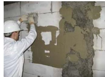
3. Нанесение Baumit Artoplast зубчатым шпателем.
